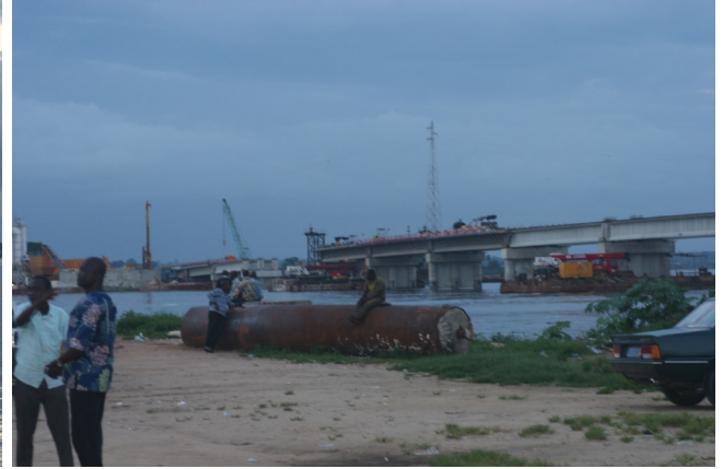
Les gens attendent le bac. Au fond, le pont à moitié construit
